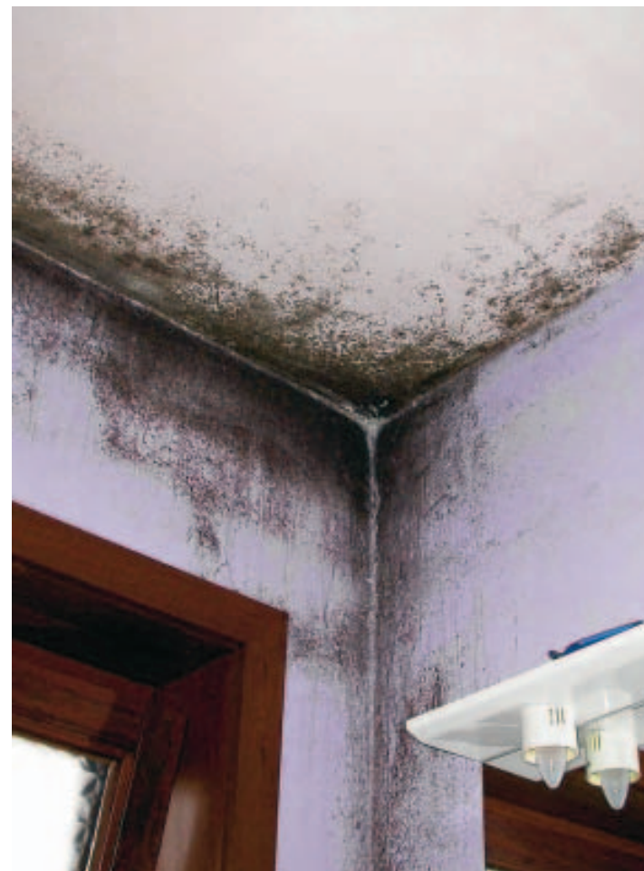
J.D. Des problèmes d'humidité ascensionnelle qui causent des dégâts
