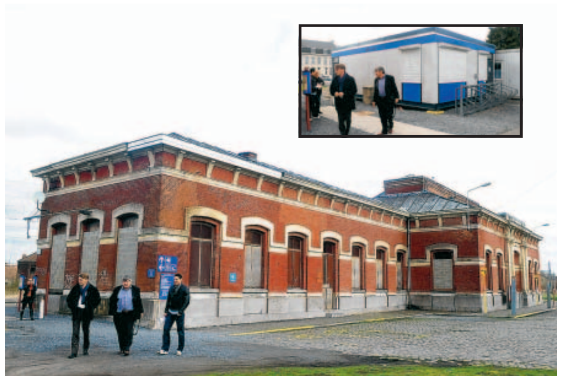
La gare de Quiévrain visitée par Thiebaut et Dorsimont: à l'abandon, remplacée par un préfabriqué. ■ E.G.
